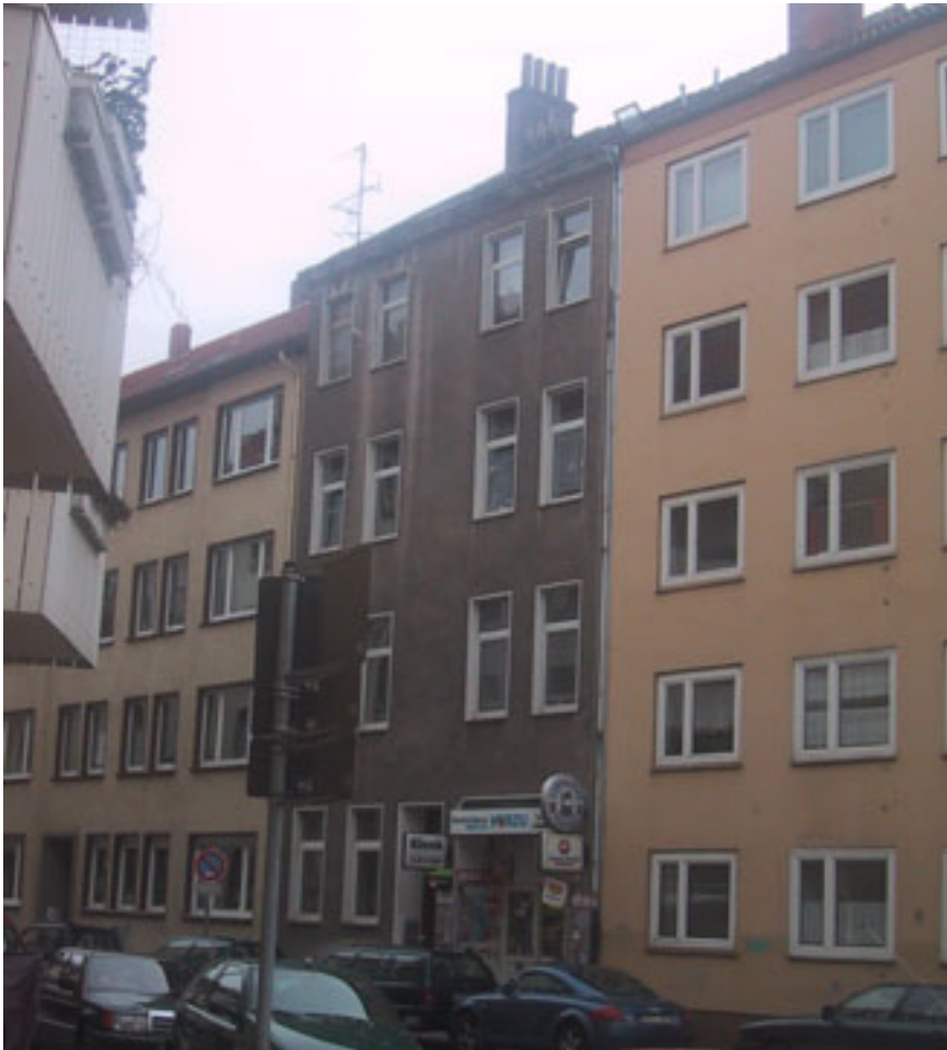
Straßenansicht vor der Sanierung
