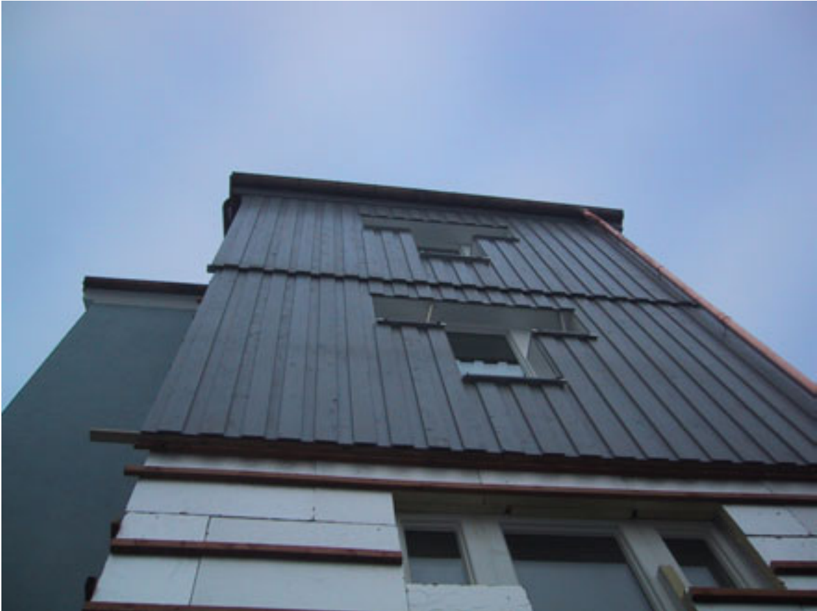
teilmertige Hoffassade / ehemalige Balkone
