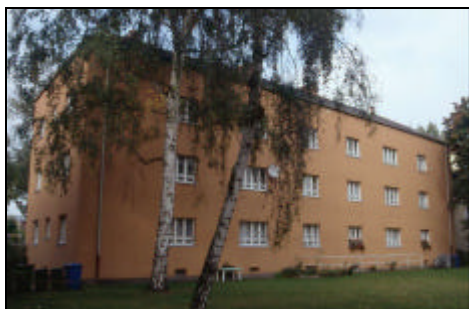
Abb. 1: Vor der Sanierung
