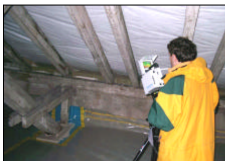
Abb. 5: Thermografie der Dachboden-Luftdichtung
