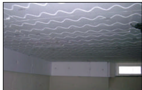
Abb. 4: Dämmung der KG-Decke und Wärmebrückenreduktion an den Wänden
